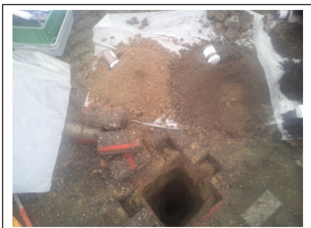
Foto: Asbestinspectiegat 210
