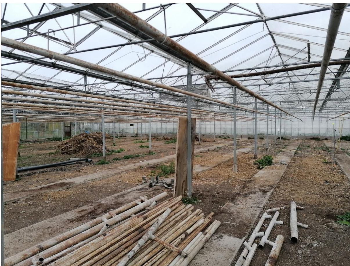
Figuur 5: Het te slopen kassencomplex. Op dezelfde locatie komen 9 kleine woningen met serres (kleine kassen).
