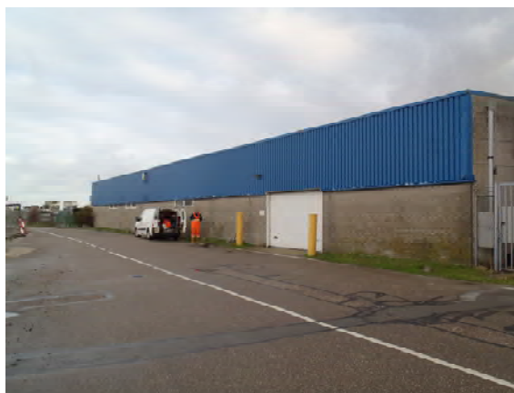
Afb. 3: impressie van de onderzoekslocatie ter plaatse van de boringen 001 en 002. De foto is genomen ongeveer richting het noorden.
