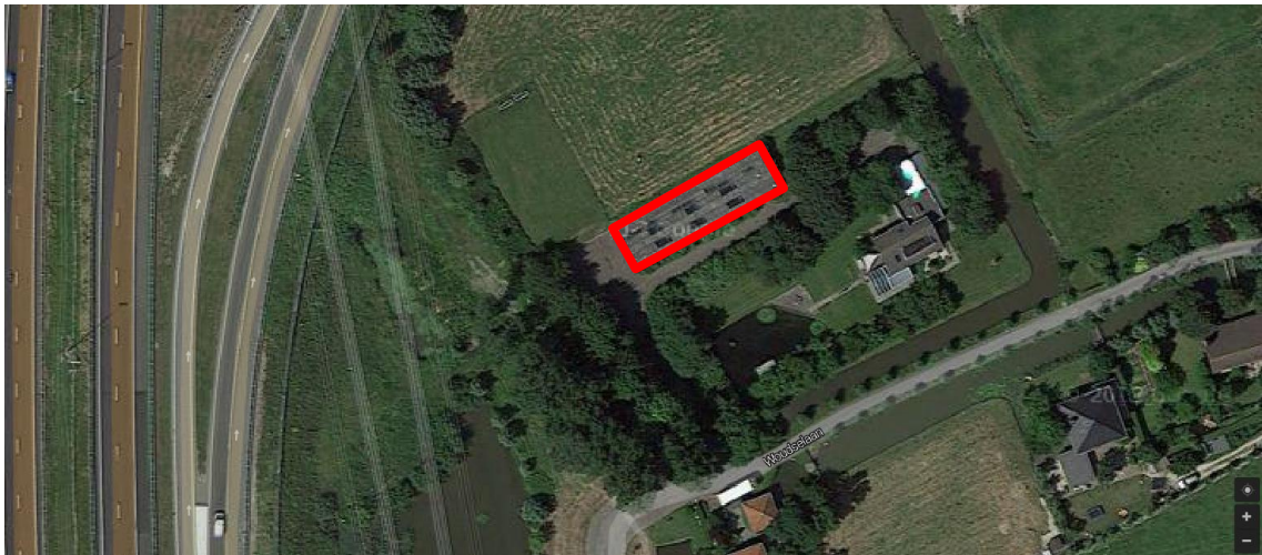
Figuur 2.4.: de schuur op het perceel Woudselaan 22 die onder het persoonsgebonden overgangsrecht is gebracht.
