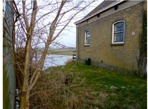
Foto 10: Ruimte tussen beide gevels.
