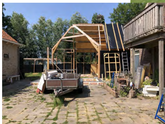
opslagschuur in aanbouw
