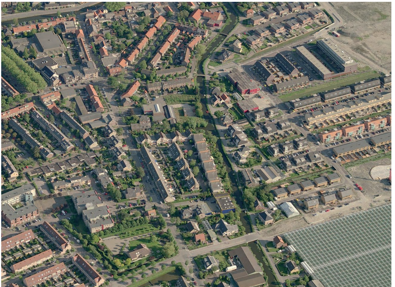
Huidige situatie luchtfoto
