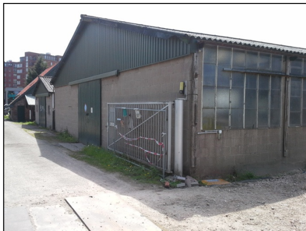
Foto 2: Oostzijde onderzoekslocatie, asfaltverharding in zuidelijke richting
