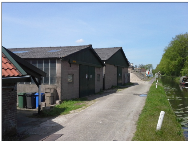
Foto 1: Oostzijde onderzoekslocatie, asfaltverharding in noordelijke richting
