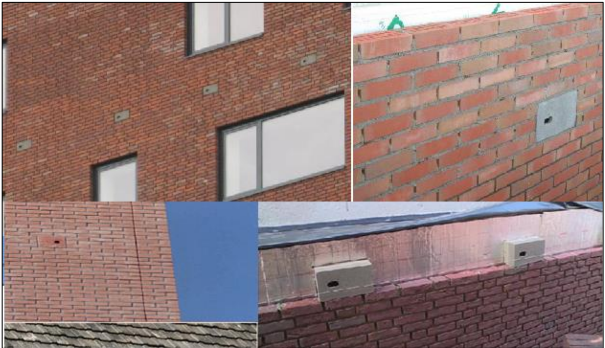
Afbeelding 9: er kunnen neststenen worden aangebracht ten behoeve van huismussen en gierzwaluwen, deze beschermde soorten verliezen steeds meer nestmogelijkheden
