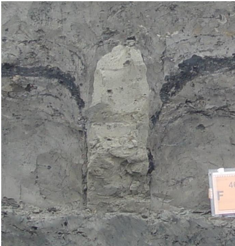
Afbeelding 4: Trechtersvormige verstoring die langzaam terugloopt tot een uitgesmeerde zone direct langs de paal. Foto: BOOR Rotterdam.
