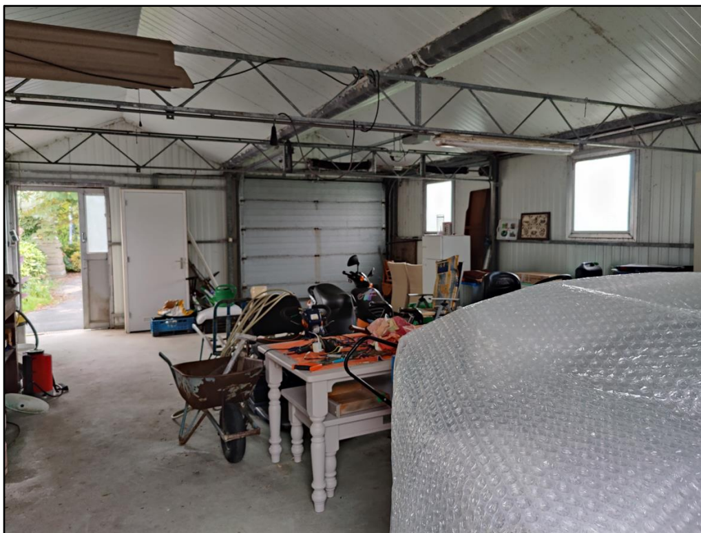
Figuur 1 De te slopen schuur op de planlocatie.
