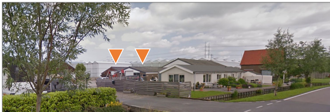
Zicht vanaf de Woudseweg op de twee bestaande loodsen (bron: google maps)
