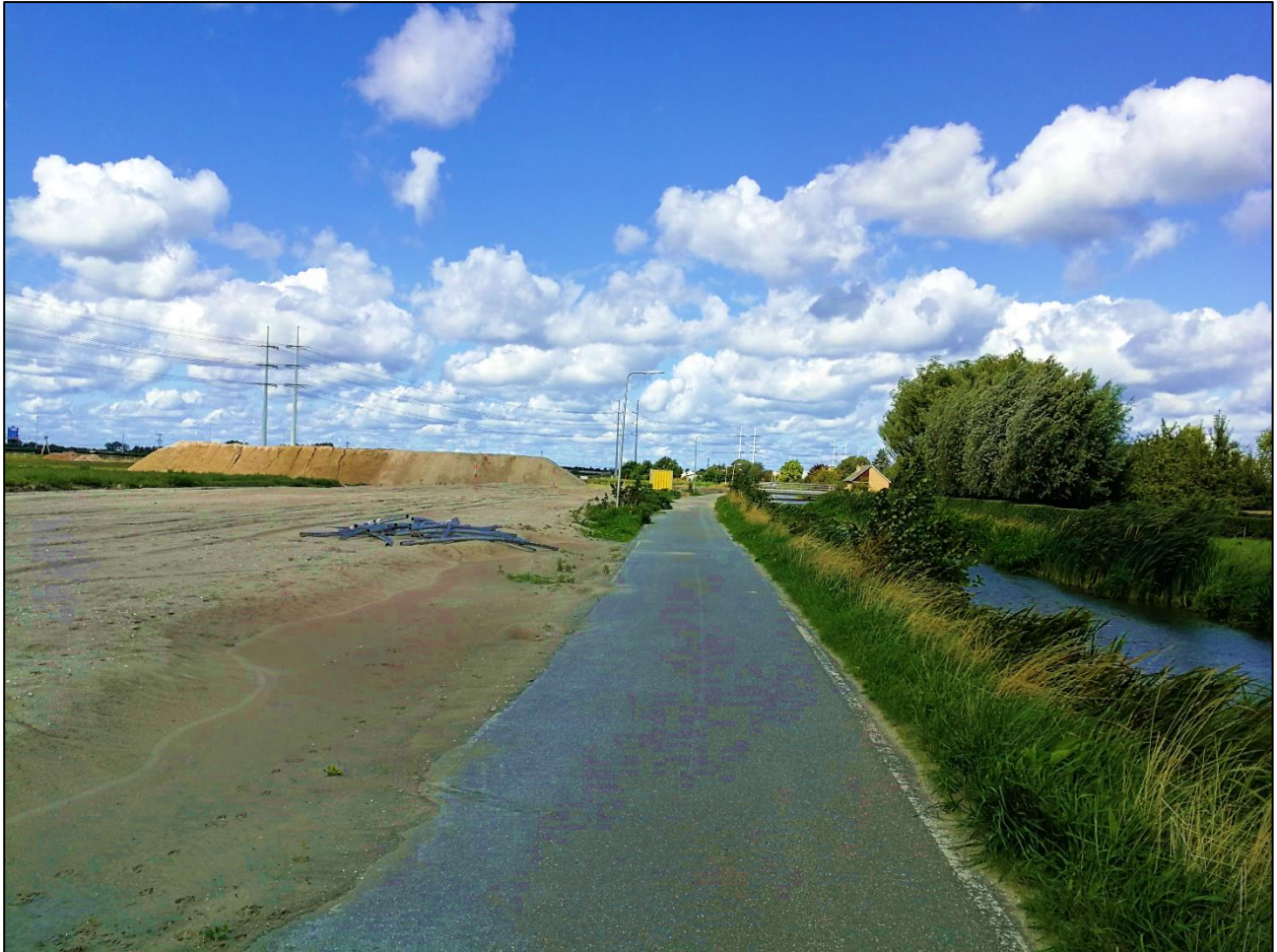
Figuur 3. De situatie aan de Harnaskade (7 september 2018).
