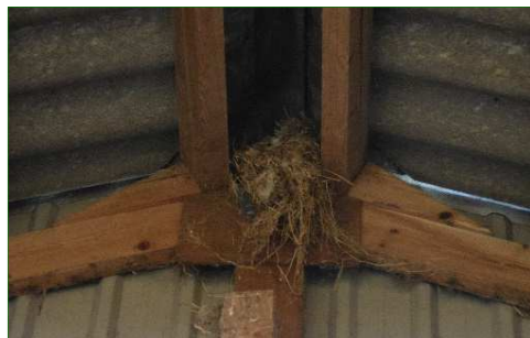
Vogelnest in de nok van de schuur.
