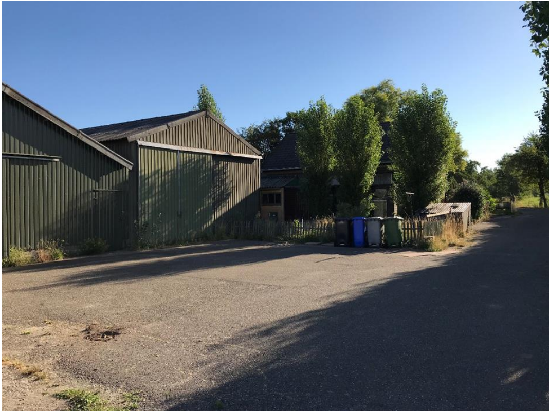
Asfaltverharding einde oprit/voor schuur
