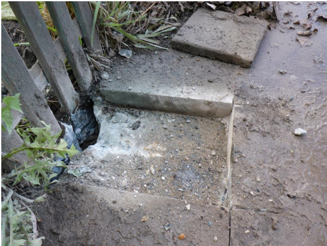
Betonplaat onder asfalt (G11-1)
