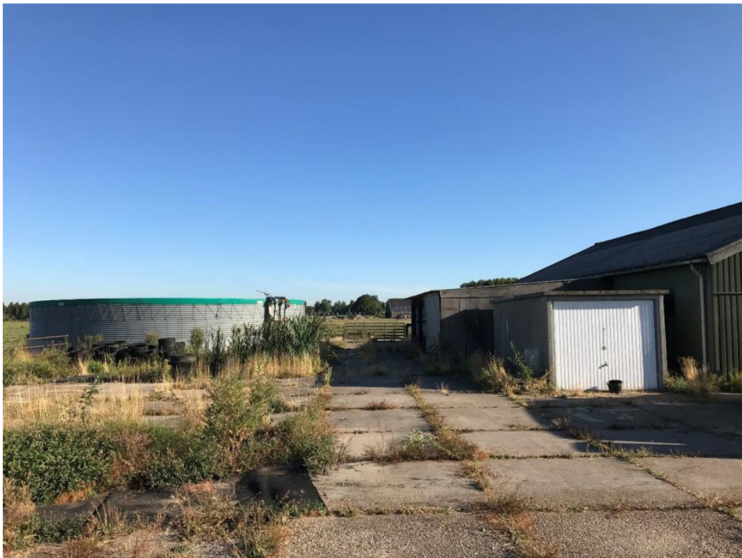
Achterterrein met stelcon in noordelijke richting
