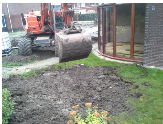
Foto 4: Situatie na aanvullen ontgravingsput
