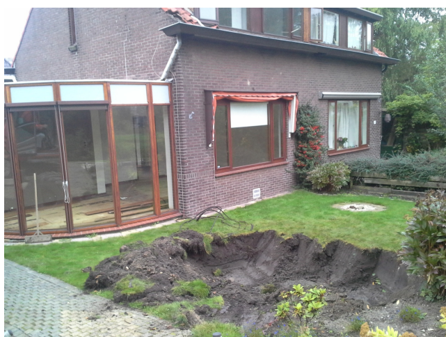
Foto 3: Gerealiseerd ontgravingscontour
