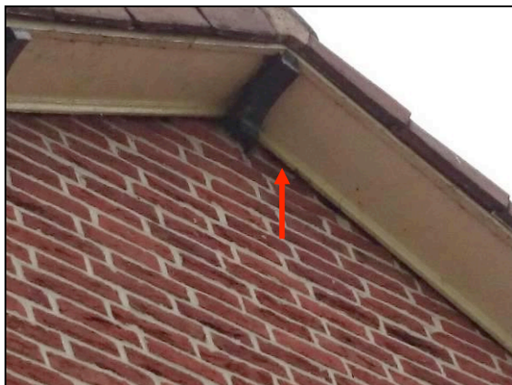
Foto 3: Spleten tussen muur en houtconstructie
