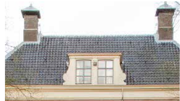
Twee kenmerkende schoorstenen op hoekpunten.
