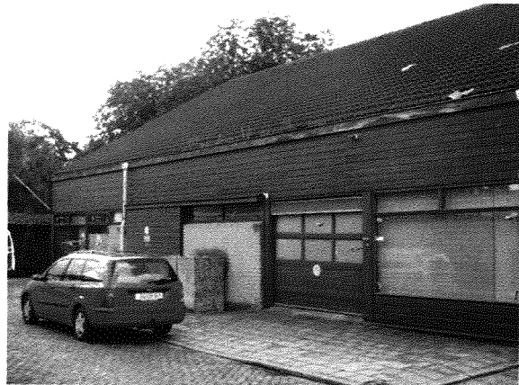
Foto 2, zicht op de voorgevel van de bebouwing
