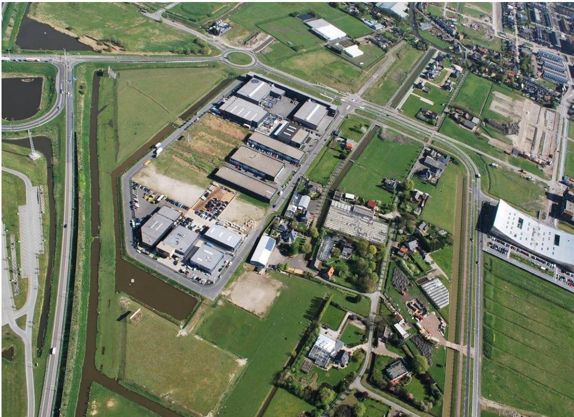
Afbeelding 2.2: situatie in april 2014 (bron: KuiperCompagnons)
