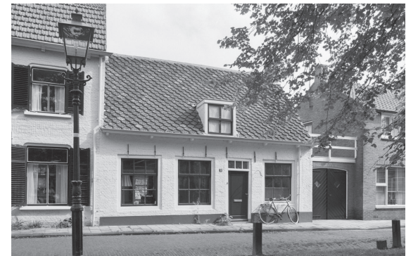
Een gebouwde muur zorgt voor de 100% bebouwde rooilijn, en geeft de Meent haar stevige karakter.
