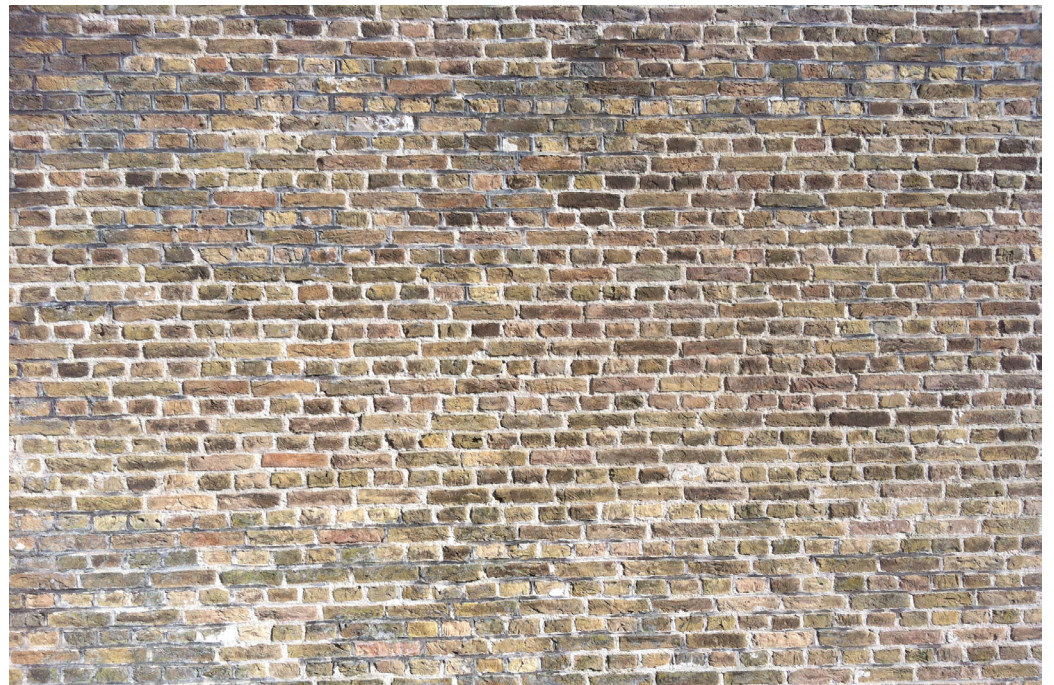
Zandkleurig gemeleerde bakstenen muur kenmerkt veel bebouwing in de directe omgeving
