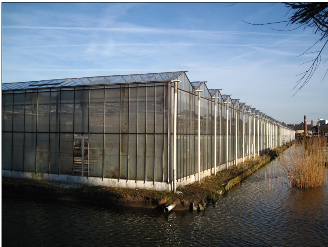
Afb. 8 Plangebied gezien in zuidoostelijke richting
