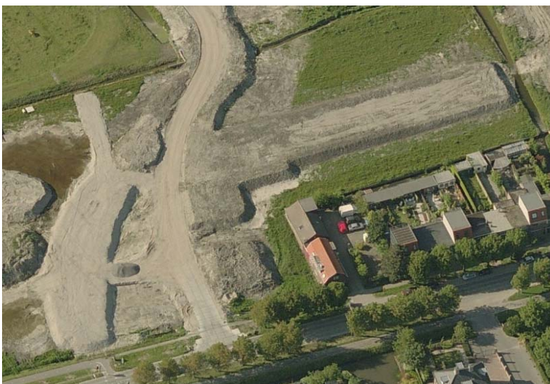
Afbeelding 2: voorbereidende grondwerkzaamheden ten behoeve van Fase 6b
