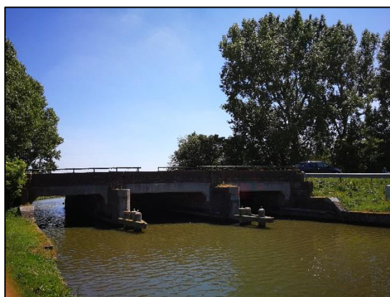
Foto 4: Brug N233 over watergang "Zijde"
