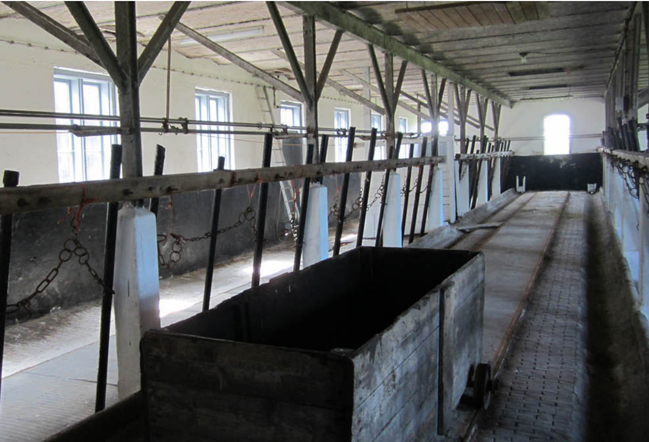
Stal met staalconstructie (brandveilig) en een tuinderslorrie in de voergang
