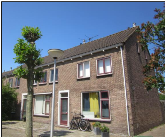
Foto 1: Eén van de woonblokken binnen het plangebied
