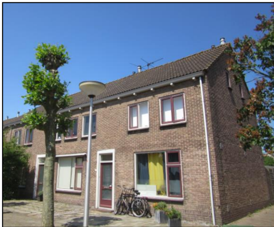
Foto 1: Eén van de woonblokken binnen het plangebied
