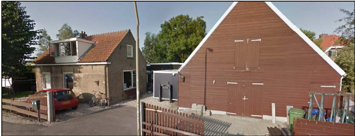
Afbeelding 4: De woning en houten schuur op het perceel Abtswoude 66.
