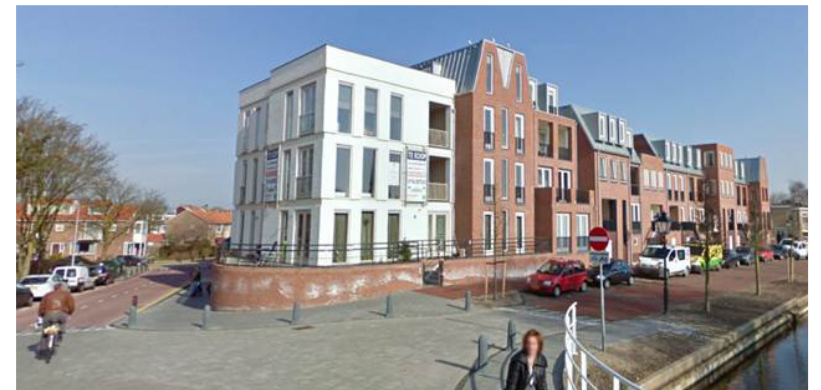
Veldesteijn-complex, hoek 's Herenstraat en Huis te Veldelaan
