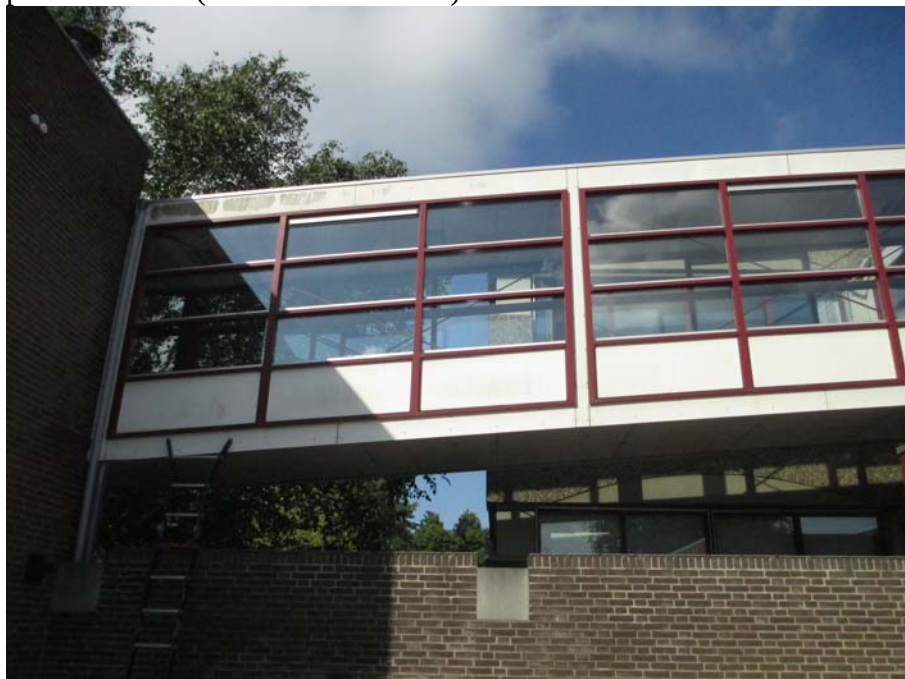
Foto 7: de loopbrug richting het voormalige gemeentehuis is geheel bekleed met trespa plaatmateriaal (niet asbestverdacht)
