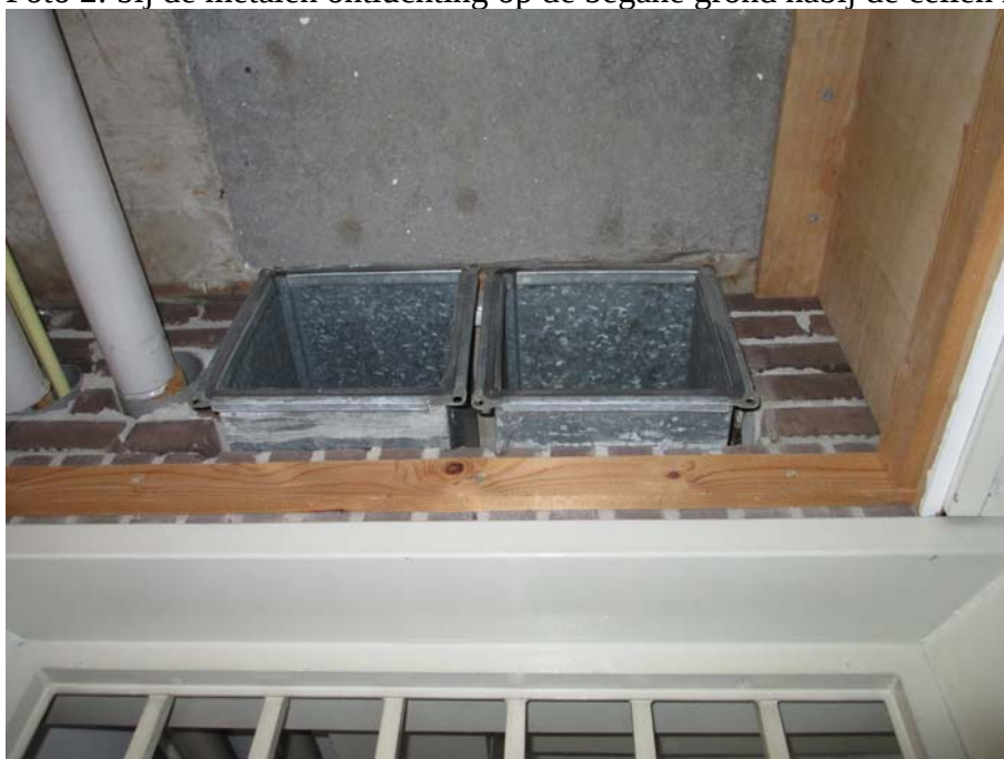
Foto 2: bij de metalen ontluuchting op de begane grond nabij de cellen is rubber toegepast
