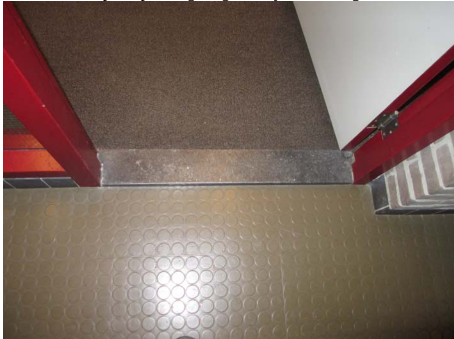
Foto 8: deurdorpels op de begane grond zijn vervaardigd van natuursteen
