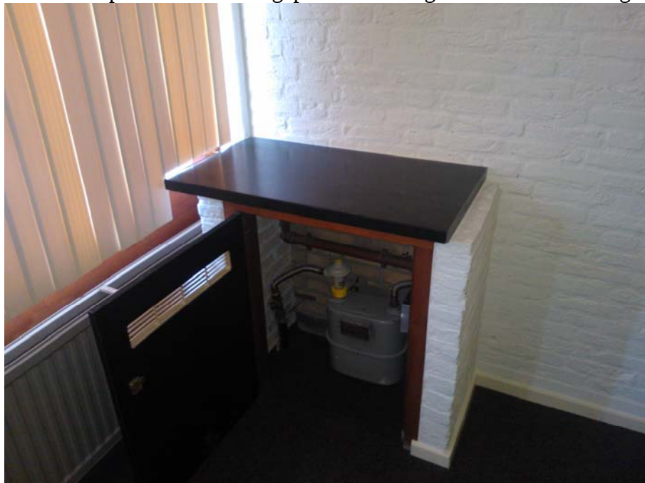
Foto 1: het plaatmateriaal toegepast boven de gasmeter is vervaardigd van natuursteen
