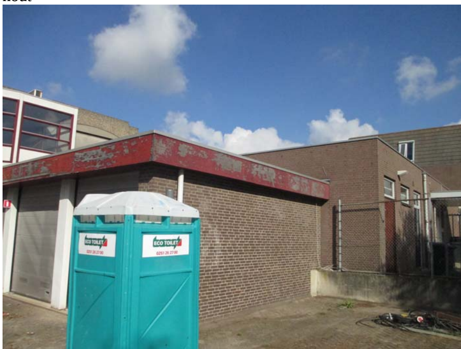
Foto 6: de dakranden van de opstallen grenzend aan het binnenerf zijn vervaardigd van hout
