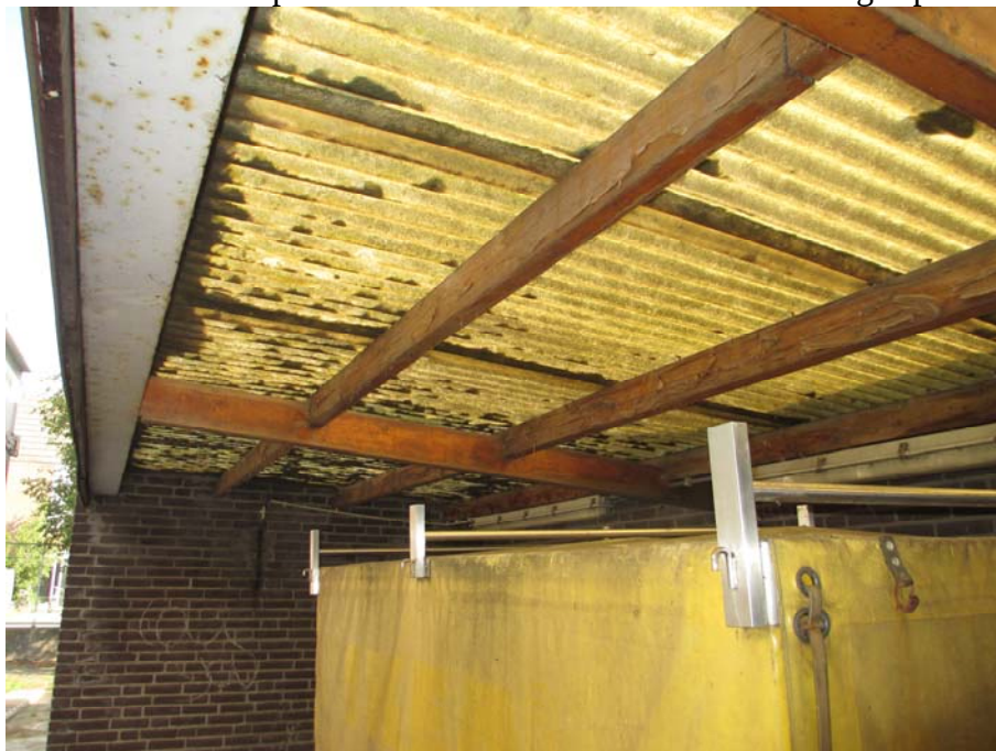
Foto 6: de dakranden van de opstallen grenzend aan het binnenerf zijn vervaardigd van hout
