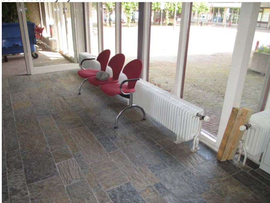
Foto 2: de ledenradiatoren binnen het gebouw zijn onderzocht waarbij is vastgesteld dat deze asbestvrij zijn
