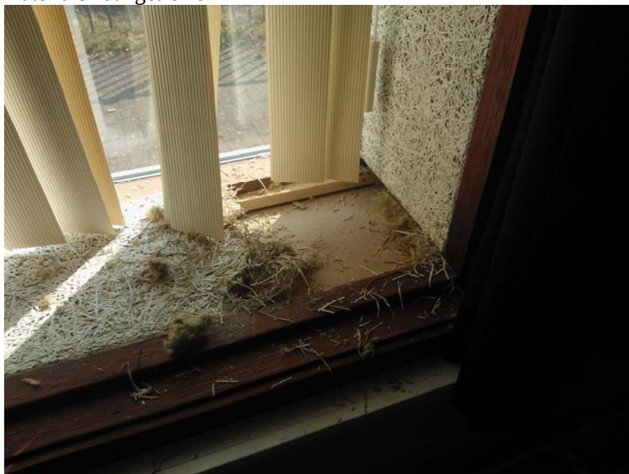
Foto 3: onder de houtwolcementplaat toegepast als vensterbank zijn geen asbestverdachte materialen aangetroffen
