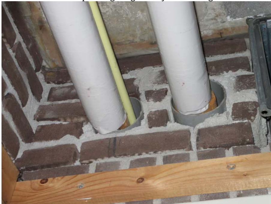
Foto 3: doorvoeren op de begane grond zijn vervaardigd van PVC
