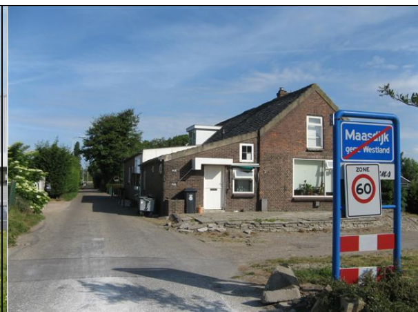
Foto 8: Woning aan Tuindersweg 35
