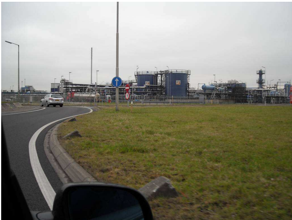
Figuur 2.6: Plangebied nabij gasbehandelingsinstallatie Gaag
