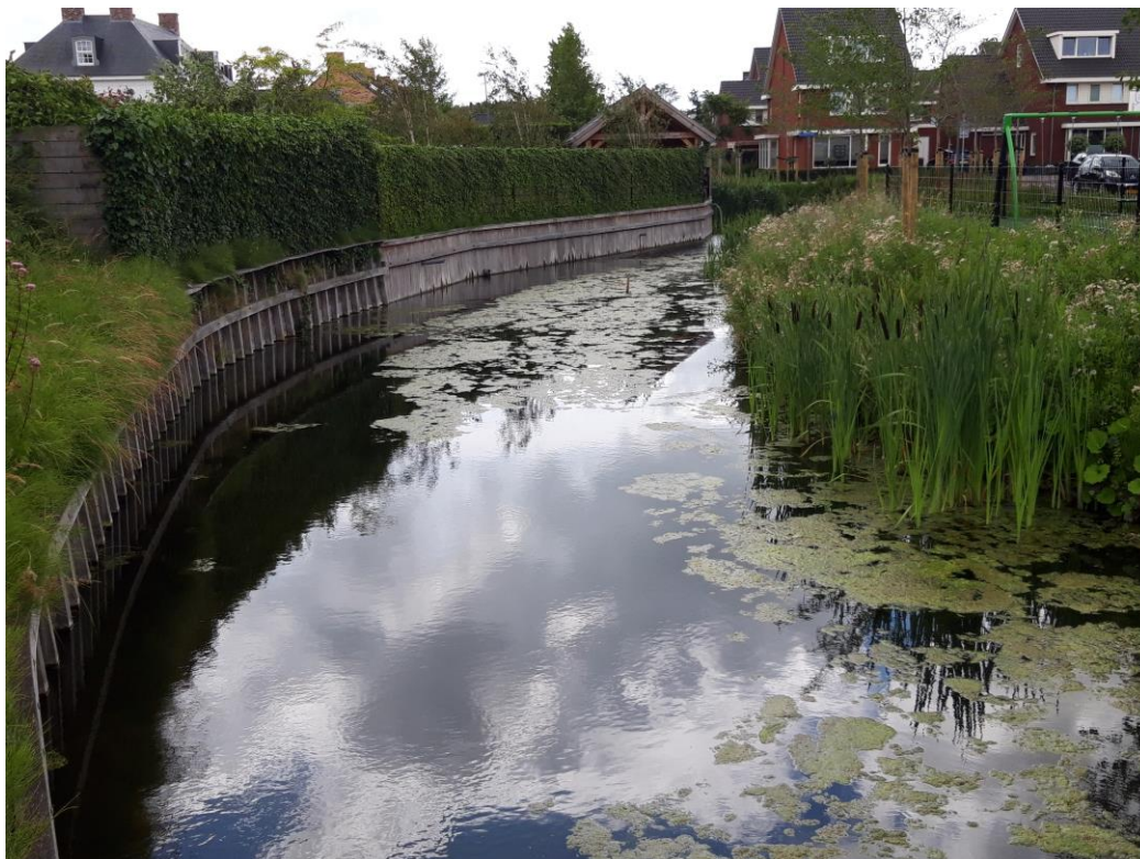
Figuur 3.8: Foto van beschoeiing (links) watergang aan de westzijde van het projectgebied
