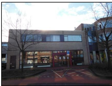
Figuur 3. Westzijde onderzoekslocatie.
