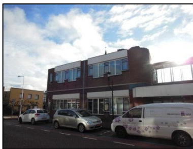
Figuur 4. Oostzijde onderzoekslocatie.
