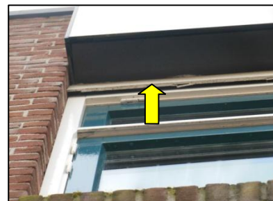
Figuur 9. Ruimte achter betimmering.
