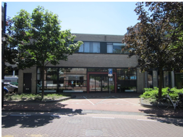
Foto 1: Aanzicht vanaf de voorzijde van het pand
