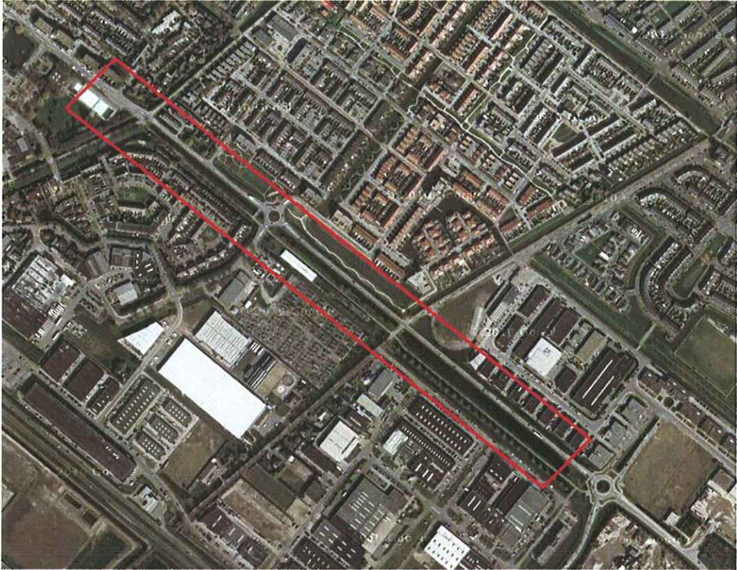
Afbeelding 1.3. Luchtfoto Projectgebied reconstructie Dorpskade Wateringen
