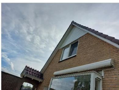
Figuur 5.9 De ten westen georiënteerde zijgevel van het woonhuis met overhangende kantpannen en openingen in de betimmering. Ook is er zonwering aanwezig.
