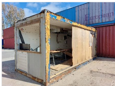
Figuur 2.4 Één van de vervallen containers op de onderzoekslocatie.
