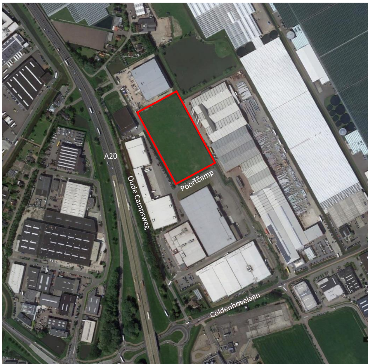
Afbeelding 2.1 Luchtfoto huidige situatie
