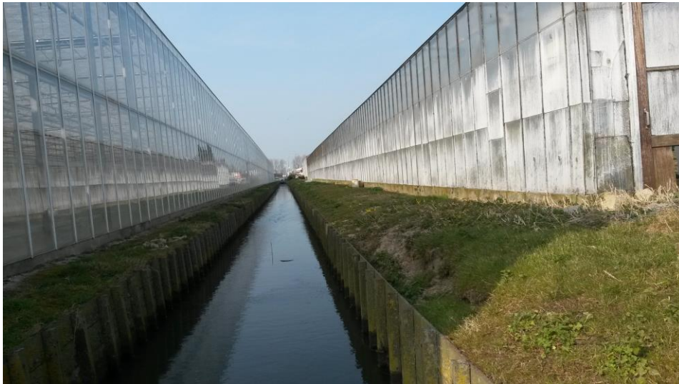
Afbeelding 5 Waterloop ten westen van het projectgebied welke zal worden verbreed
