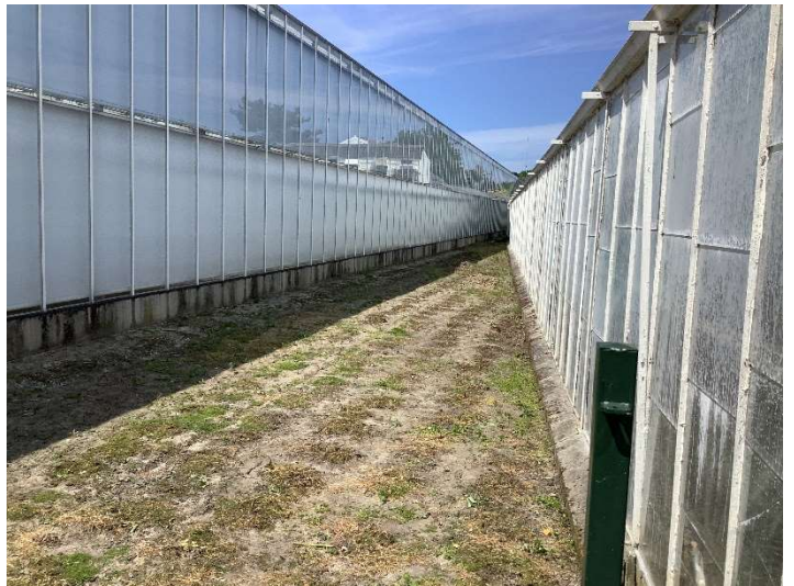
foto 2: achterzijde kas (westelijke deel van de locatie)
