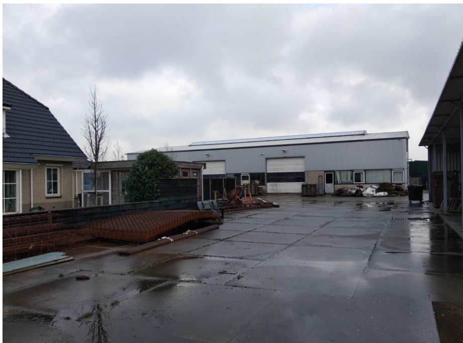
Figuur 2: Foto van het terrein en van de bedrijfshal.
