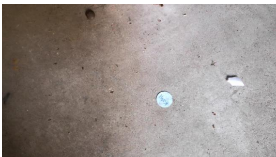
Foto 7. Niet-asbesthoudende inkadering (bron Bron2)
