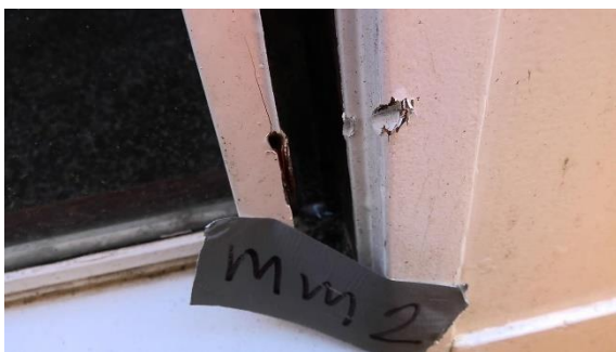
Foto 13. Niet-asbesthoudende beglazingskit (bron Bron3)
