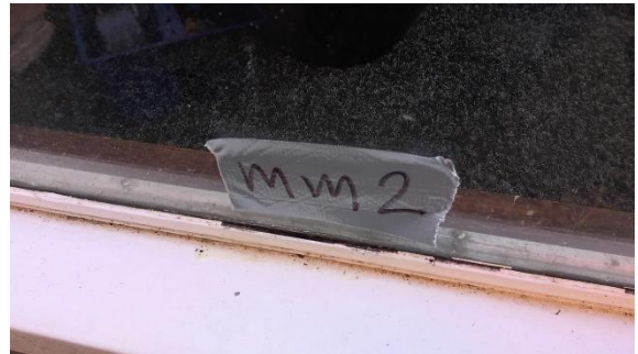
Foto 12. Niet-asbesthoudende beglazingskit (bron Bron3)
