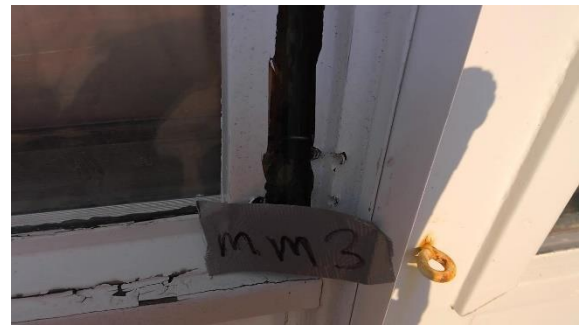
Foto 18. Niet-asbesthoudende beglazingskit (bron Bron3)
