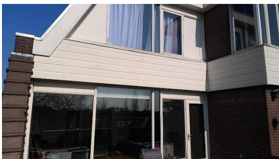
Foto 15. Niet-asbesthoudende beglazingskit (bron Bron3)
