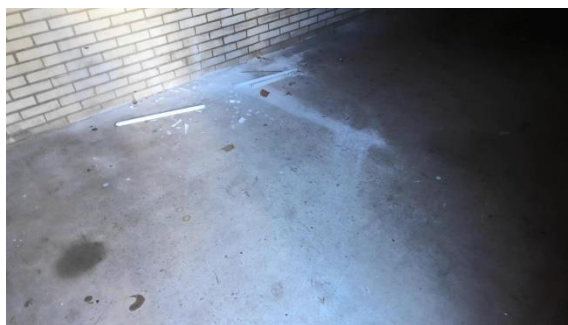
Foto 6. Niet-asbesthoudende inkadering (bron Bron2)
