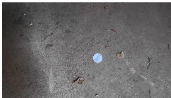
Foto 8. Niet-asbesthoudende inkadering (bron Bron2)
