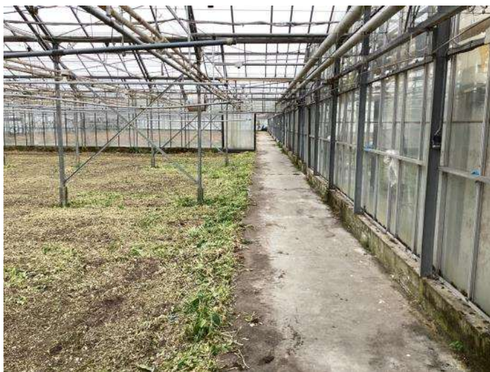
foto 2: binnenzijde kas deellocatie bestrijdingsmiddelen
