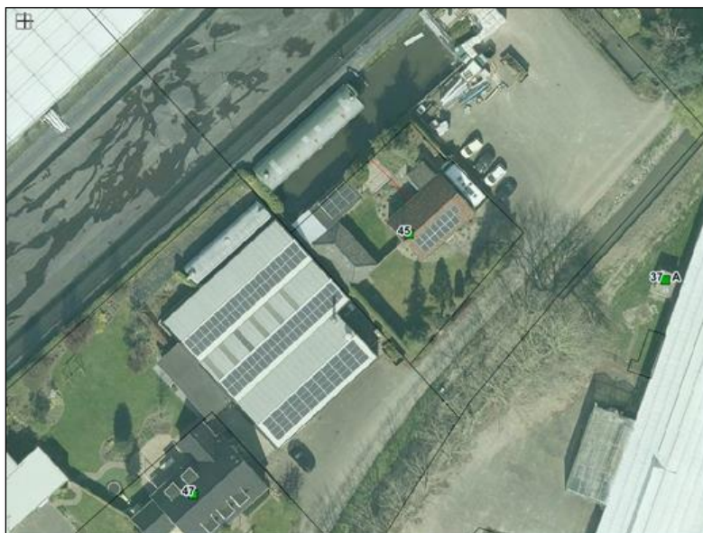
Figuur 1: Afstand tussen de woning aan de Noord-Lierweg 45 en het terrein van [REDACTED] aan de noordwestzijde = 9,35 meter.
