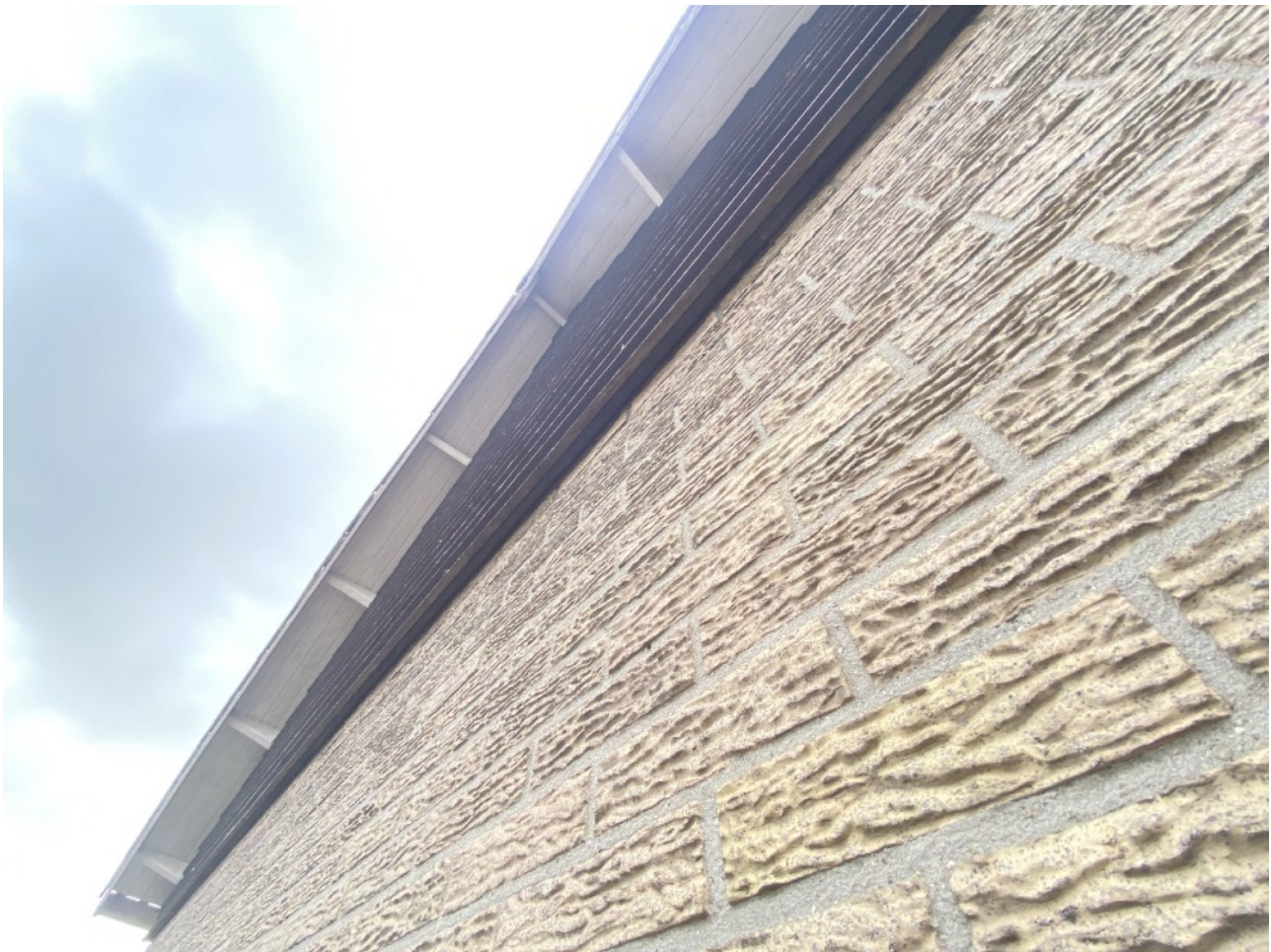
Afb.3: Detail van de gevelbekleding. Niet toegankelijk voor vleermuizen.
