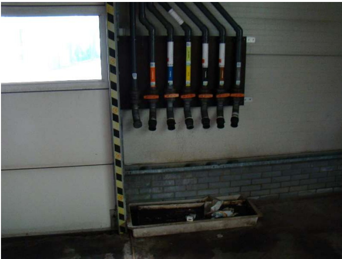
foto 21: Poelkade 32B (vulpunt vloeibare meststoffen)
