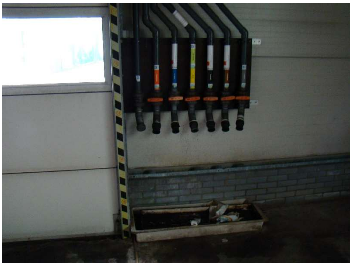
foto 21: Poelkade 32B (vulpunt vloeibare meststoffen)
