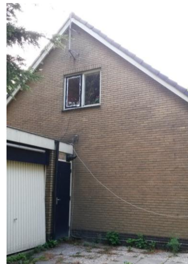
Foto 6. Woning nr. 6 waarvan nog niet zeker is of de woning wordt gesloopt.
