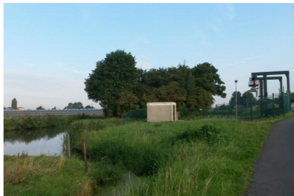
Foto 2. Gemaal langs de Blakervaart met aan de linkerkzijde de waterloop.
