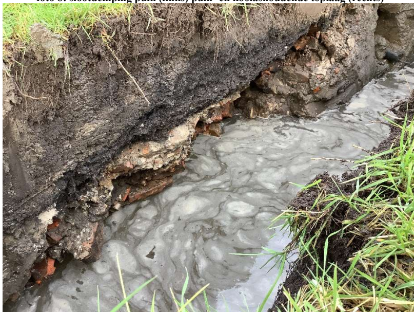
foto 9: dwarsdoorsnede slootdemping
