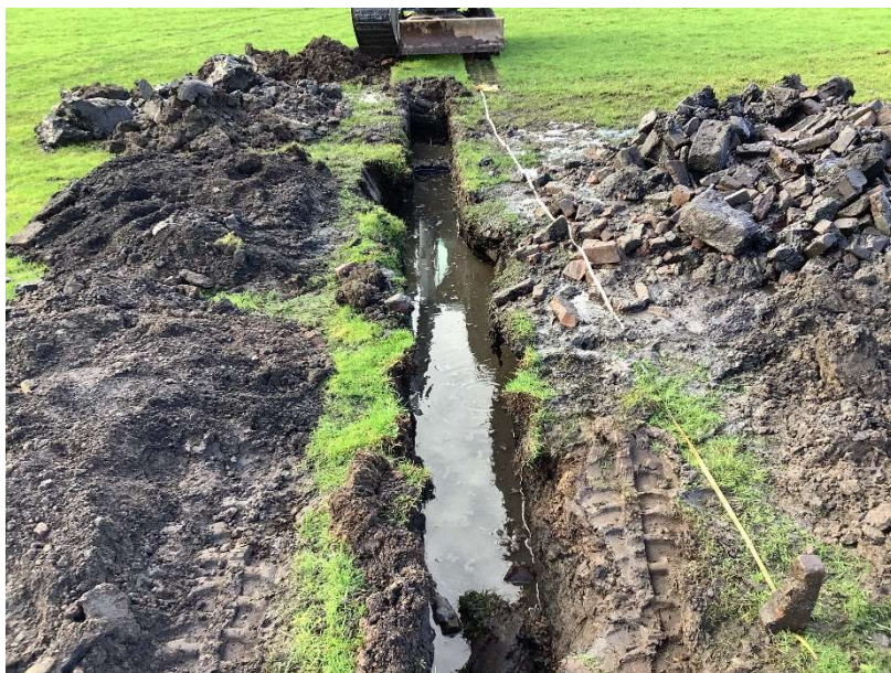
foto 7: proefsleuf ± 7 meter t.b.v. schets dwarsprofiel
